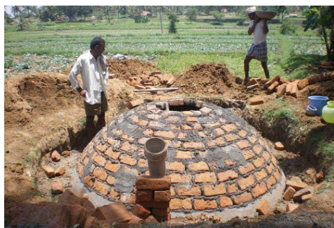
Construction de réservoir à Biogaz en Inde Programme Action Carbone
