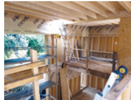
un procédé constructif innovant.
