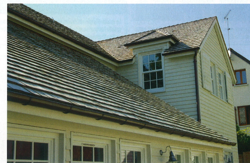
L'ensemble de la toiture est couvert par des bardeaux de bois. C'est là un trait caractéristique du travail d'Isabel Jacquinot qui souligne que les éléments rosés en douglas grisent progressivement.
